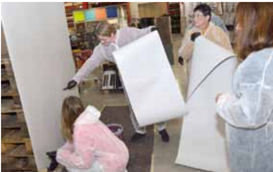
...mit Kleister und Tapete oder mit Rolle und Farbe weitergeht. Wichtig: Die Einwirkzeiten des Kleisters!
