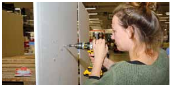
...was auch für Rigipsplatten gilt, die auch mit speziellen Dübeln behandelt werden, wie die Teilnehmerinnen erfuhren.
