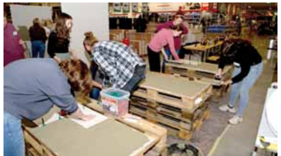
Beim Fliesenlegen bedarf es umfangreicher Vorbereitungen und einer besonderen Akkuratessse. Wer diese – gepaart mit dem nötigen Know how – walten lässt...
